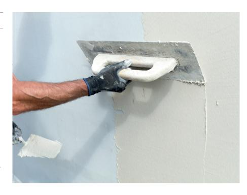
con MORTERO WT OPTIMA de REVETÓN® (incorporando malla de fibra de vidrio en soportes muy fisurados o en aplicaciones de gran espesor).
