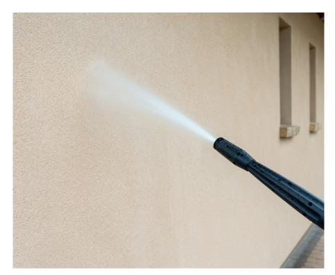
Con el fin de conseguir una mayor vida útil del sistema y por consecuencia de la fachada será necesario prever operaciones de mantenimiento. Su proceso de envejecimiento y deterioro depende de variables muy diversas: el microclima al que está expuesta, las características de los materiales que la componen e incluso su morfología y la situación del edificio.
