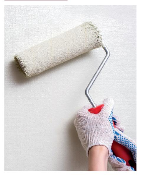
La imprimación es una composición de baja viscosidad que tiene 3 funciones principales: potenciar la adherencia del revestimiento continuo al soporte, consolidarlo superficialmente y sellarlo para regularizar el grado de absorción del producto de acabado evitando defectos estéticos, especialmente al aplicar colores intensos.
