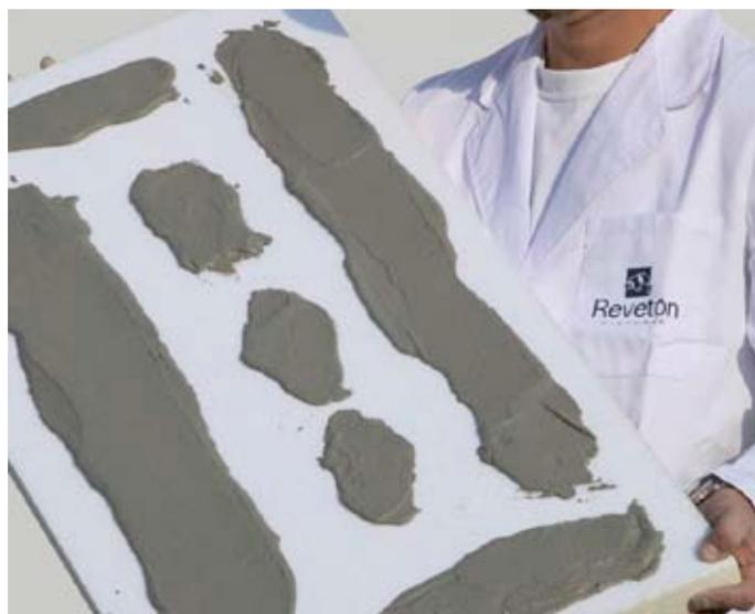
Se colocan los paneles juntando los bordes de uno y otro, de forma horizontal en filas sucesivas y a "rompejuntas", a partir del nivel inferior establecido por el perfil de arranque. Es necesario asegurar que las placas están bien pegadas acompañando la presión sobre el soporte con un ligero vaivén y controlando con un nivel la planimetría de las hiladas.
