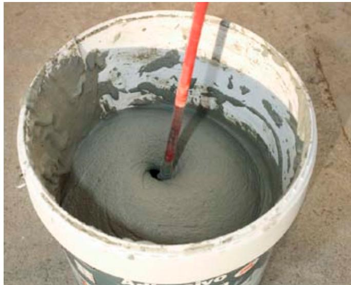
El adhesivo, así preparado, se aplica sobre las placas formando un cordón perimetral, colocado de 3 a 4 cm del borde de la placa de manera que evita la penetración de la pasta en las juntas; se complementa el cordón perimetral con tres puntos centrales. Debe evitarse el relleno de las juntas entre placas. En el cordón se reservarán unos 5 cm sin pasta con el fin de que pueda escapar el aire al presionar la placa.
